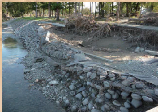
H29年度まるごと再生による自然石護岸の決壊。 「くらかけ清流の郷 右岸堤防」
