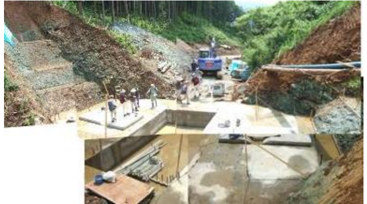
工事中の以後ヶ谷 上流側堰堤 基礎工事
