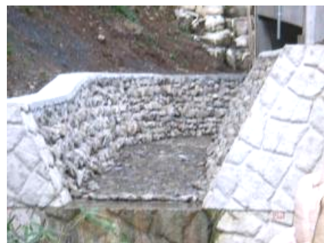
慈光寺川 整備中の場所（中流部）
