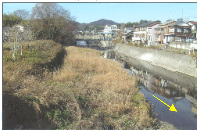
現況 (相生橋から上流)
